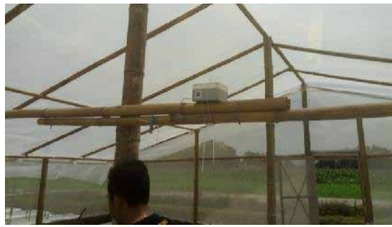
Pemasangan sensor kelembaban dan suhu udara
